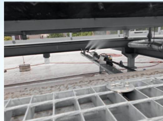
Bei der Verdunstung von Wasser wird Wärme benötigt. Das Wasser holt sich diese Wärmeenergie aus der Umgebungsluft. Hierdurch entsteht Kälte, die Sie direkt auf der Haut oder Produkten messen bzw. spüren können. Die menschliche Haut signalisiert dies umgehend mit Gänsehaut, weil die plötzliche Abkühlung so enorm ist, dass der Körper sofort reagiert.
